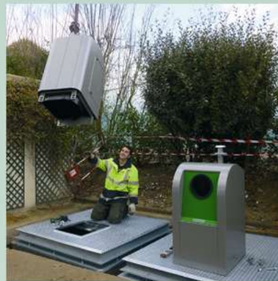
Implantation des conteneurs enterrés pour le verre à Adainville, le 17 novembre 2011.
